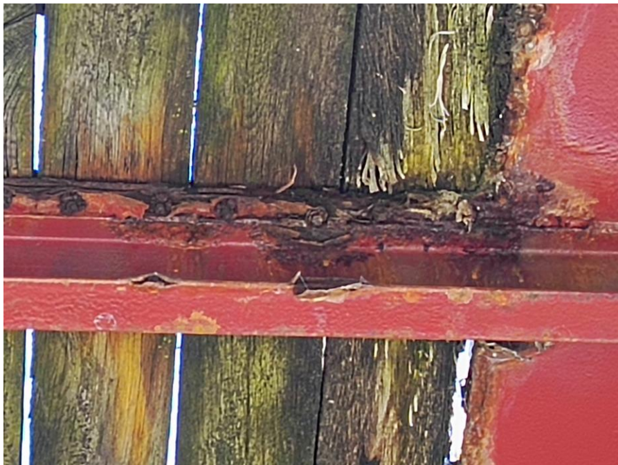
Pohled ze spodu na uzavřené části lávky, velké poškození korozními produkty.
