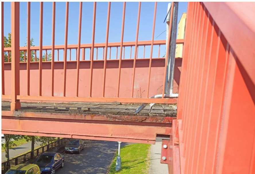
Pohled ze strany od Růžového pahorku směr Místek- prokorodovaný okopový plech
