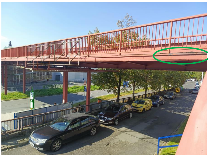
Pohled ze strany od Růžového pahorku směr Místek- prokorodovaný okopový plech
